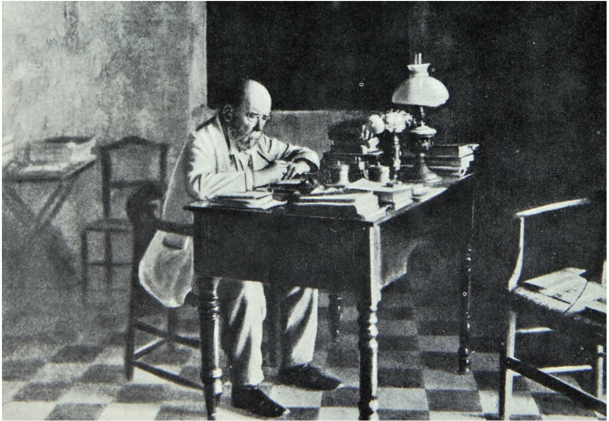
Teodor Llorente treballant a casa.
