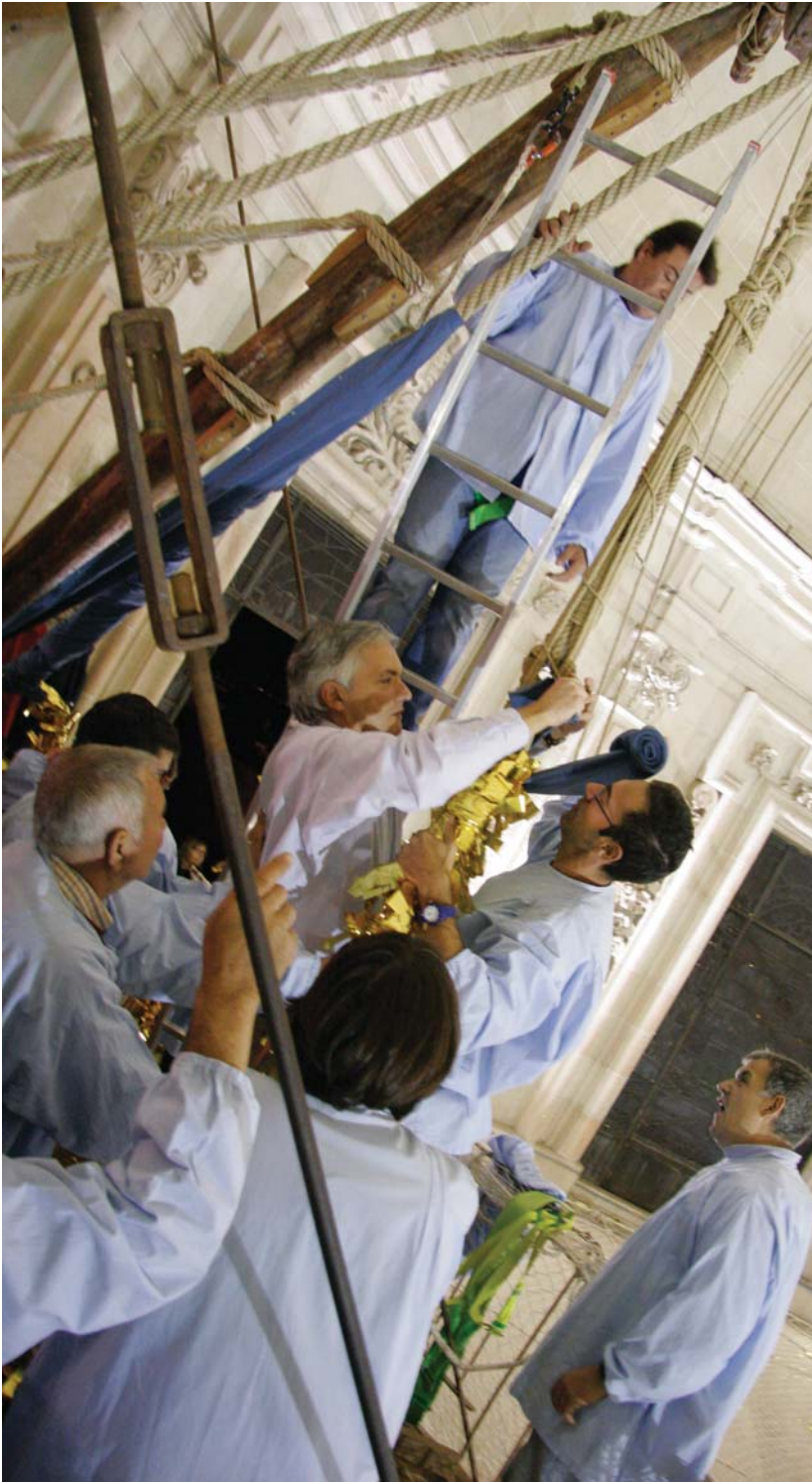
Tramoia instal-lada en la cúpula del temple
