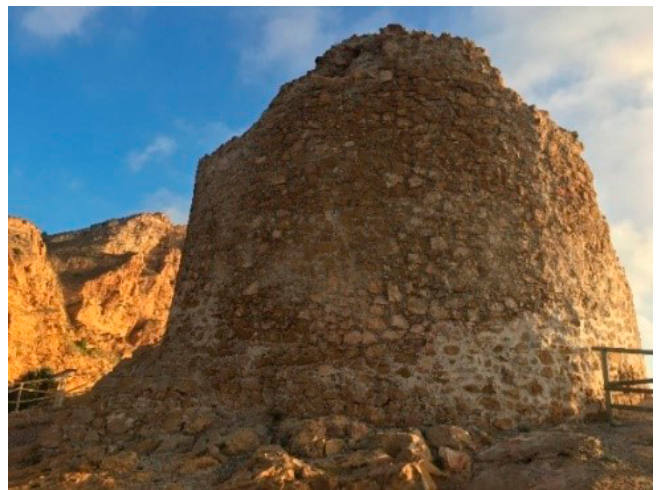
La torre després de la reconstrucció de 2021 (Pasqual Almiñana Orozco)
